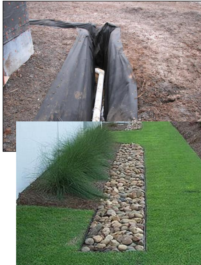
Esempi di trincee drenanti
