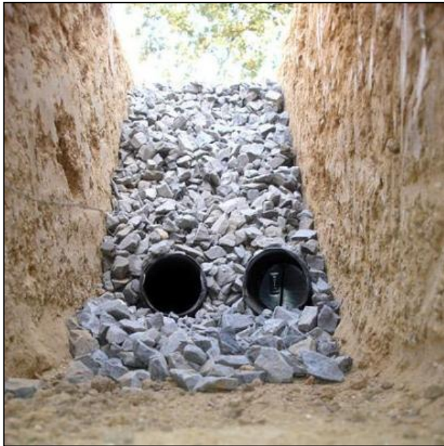
Esempi di trincee drenanti
